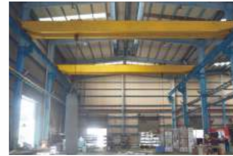
大型龙门吊 Crane
